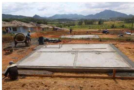
Figura 6. Construcción de vereda perimetral
