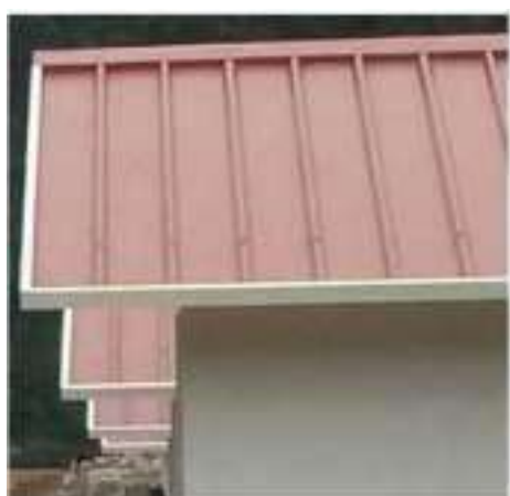
Figura 20. Teja TPR 40 con aislamiento termoacústico (PIR)
