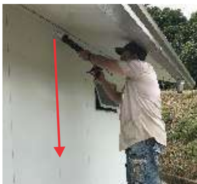
Figura 37. Aplicación del sellante
