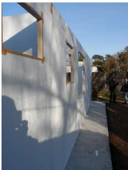
Figura 9. Panel ventana en obra
