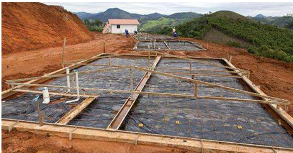
Figura 12. Platea lista para ser rellena, con espacio para sanitaria y eléctrica
